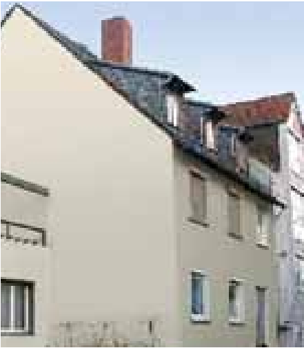
1. Haus, von dem eine Thermografieaufnahme erstellt wird
