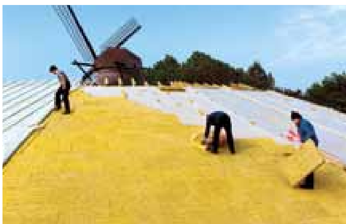
Aufsparrendämmung, Quelle: Deutsche Rockwool Mineralwool GmbH & Co. OHG
