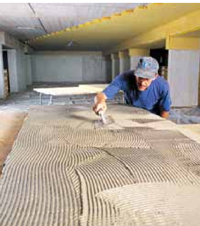
Kellerdeckendämmung von unten, Quelle: Deutsche Rockwool Mineralwool GmbH & Co. OHG
