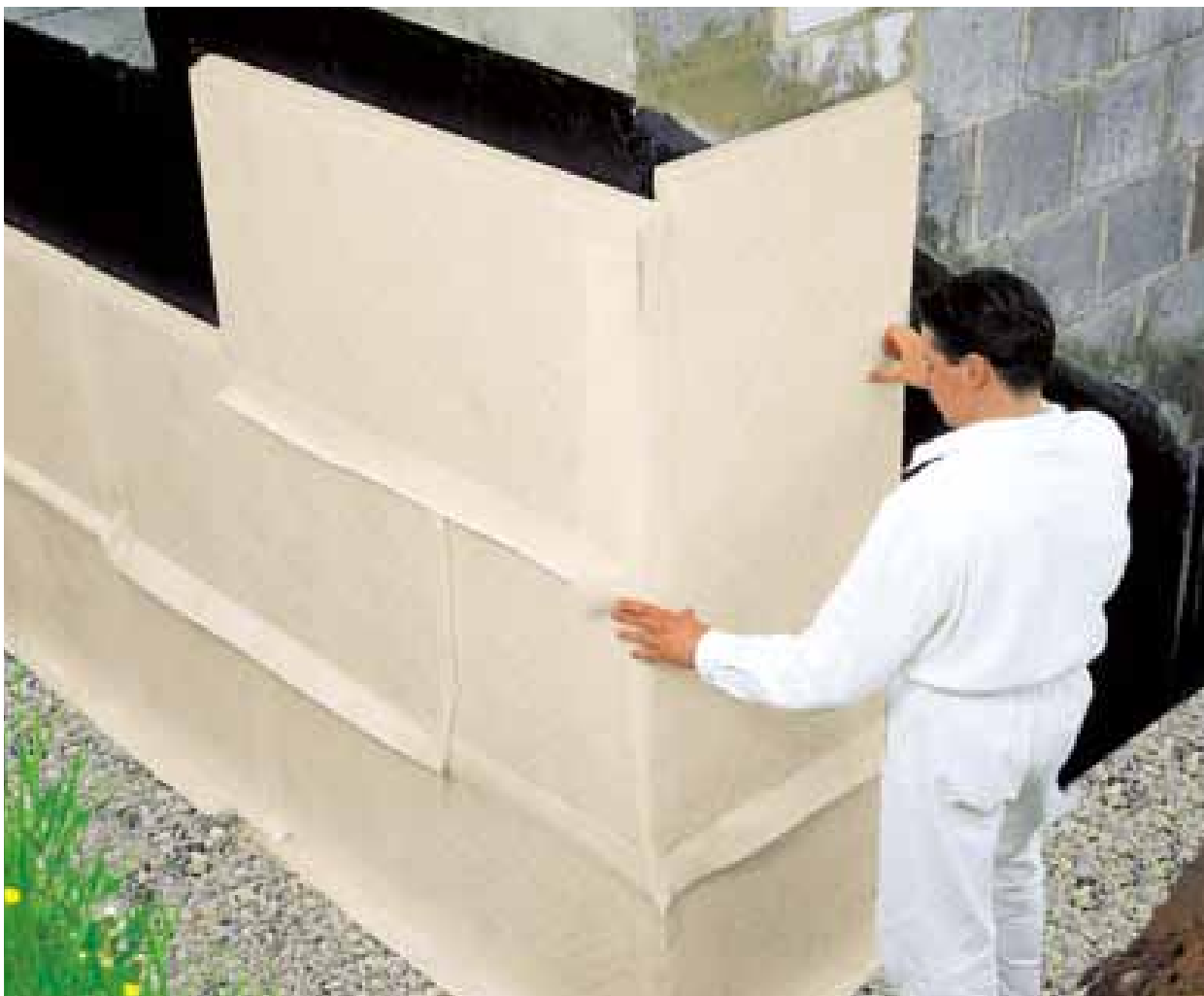
Perimeterdämmung der Kellerwände, Quelle: Rigips GmbH
