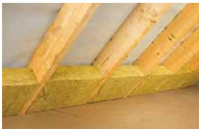
Zwischensparrendämmung, Quelle: Deutsche Rockwool Mineralwool GmbH & Co. OHG
